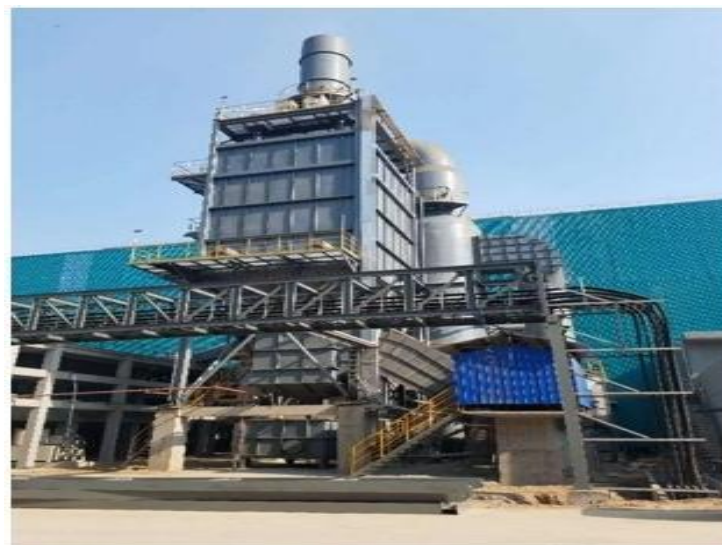
山西晋南钢铁二期炼钢系统辊压破碎有压热闷渣处理除尘及超低排放系统
