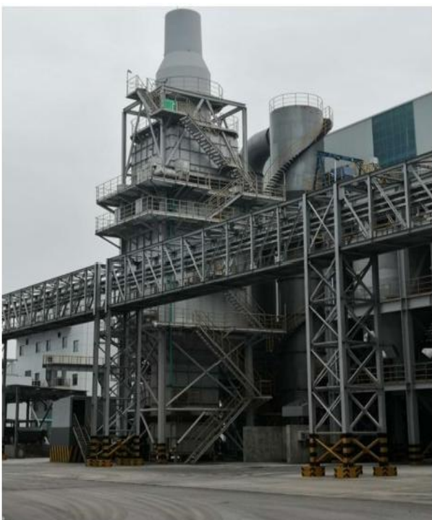
山东永锋钢铁渣处理湿式变流除尘系统+湿式电除尘超低排放+消白系统
