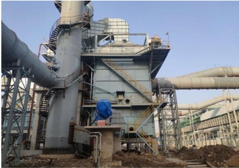
唐山丰南纵横炼钢厂一、二车间钢渣处理湿式电除尘超低排放系统
