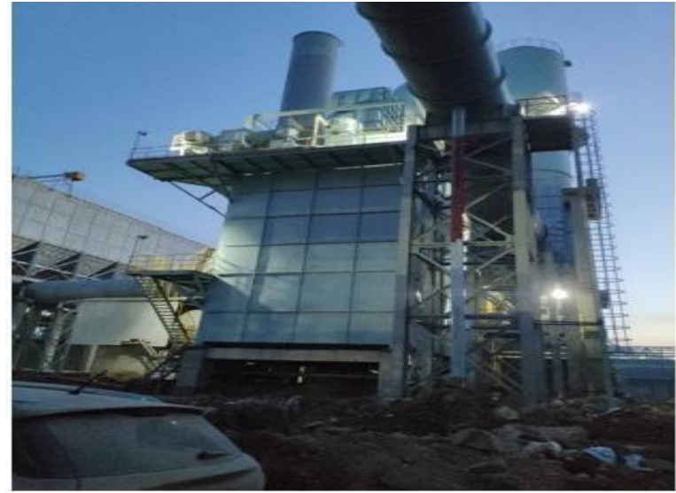
唐山丰南纵横炼钢厂一、二车间钢渣处理湿式电除尘超低排放系统
