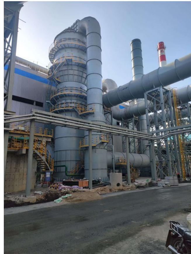
泉州闽光钢铁渣处理辊压热焖处理除尘+热泼处理除尘
