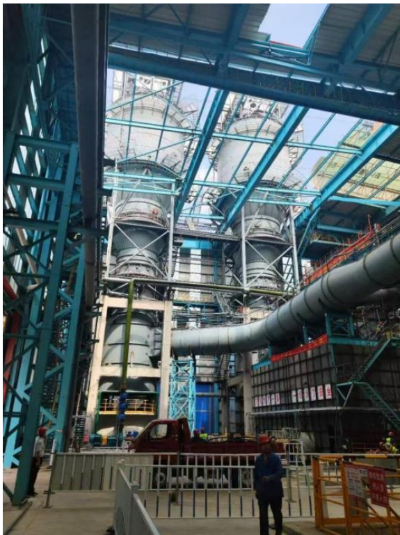
山东石横特钢炼钢煤气回收降温工程喷雾降温装
