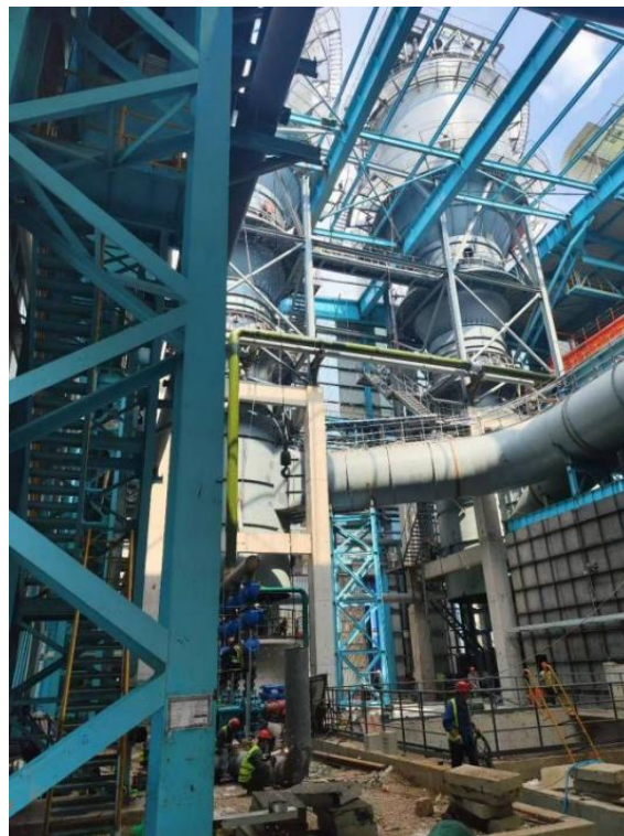
山东石横特钢炼钢煤气回收降温工程喷雾降温装
