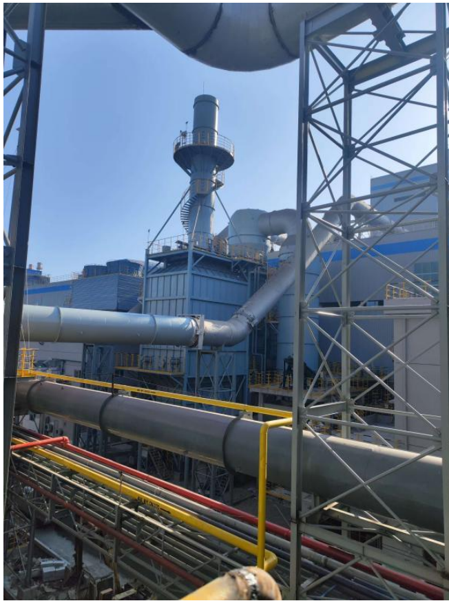
泉州闽光钢铁渣处理辊压热焖处理除尘+热泼处理除尘
