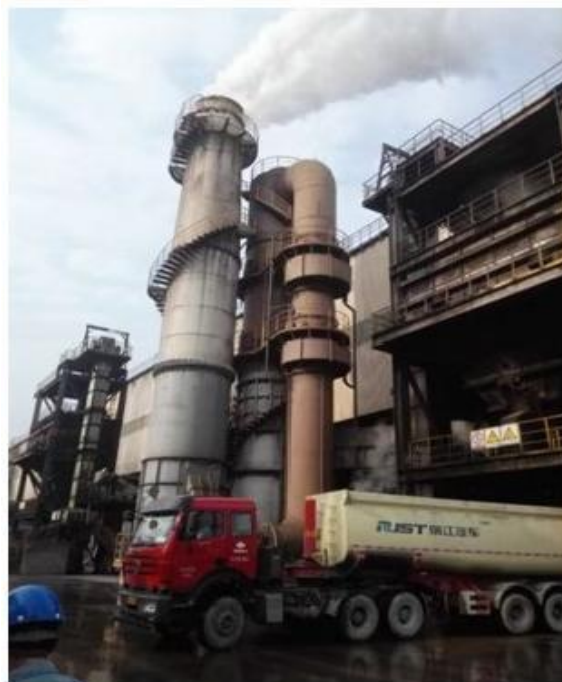
宝钢二炼钢渣处理 4#渣处理湿式 变流除尘系统
