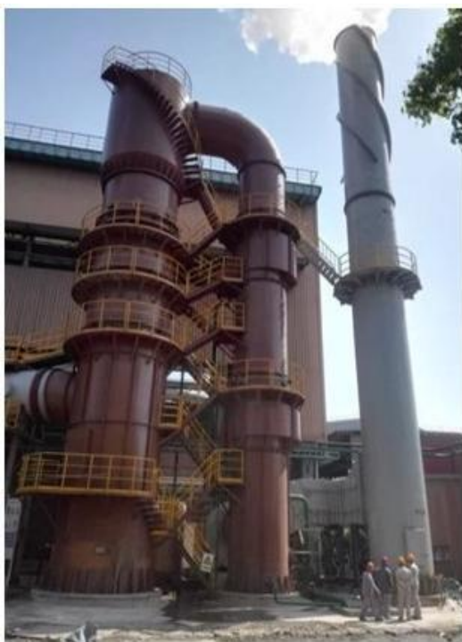
梅山钢铁一炼钢渣处理渣处理 湿式变流除尘系统
