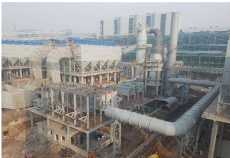
唐山丰南纵横炼钢厂一、二车间钢渣处理喷淋除尘系统
